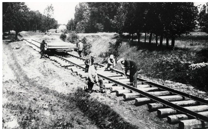
Рис. 1. Укладка рельсов в Латвийской ССР
